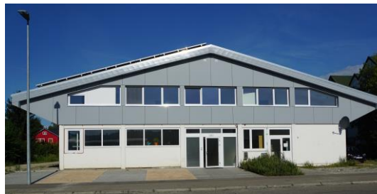
Neues Gebäude der BVE in Singen
